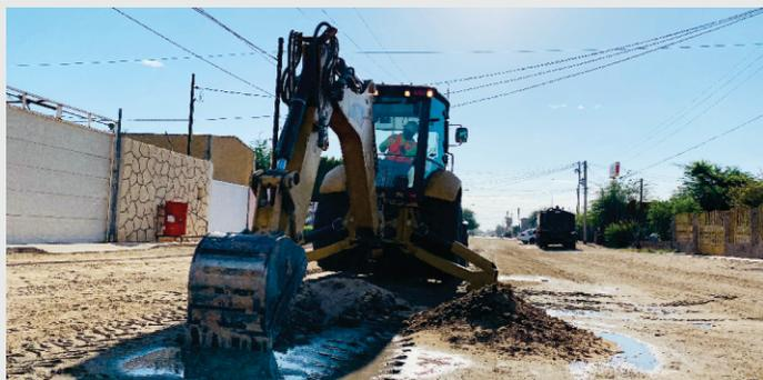
Suministro, instalación y prueba de 5,141 metros lineales de tubería SDR35 de 8" de diámetro; construcción de 55 pozos de visita; construcción de 120 descargas domiciliarias; construcción de dos cárcamos de bombeo y dos emisores de 3" y 4" de diámetro respectivamente. Beneficiando a 480 personas mediante una inversión de \$7'618,632.69
