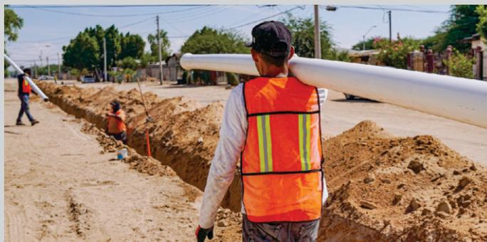
Suministro, instalación y prueba de 2,780 metros lineales de tubería SDR35 de 8" y 10" de diámetro; construcción de 26 pozos de visita y construcción de 121 descargas domiciliarias. Beneficiados 520 personas con una Inversión de \$3'221,443.52
