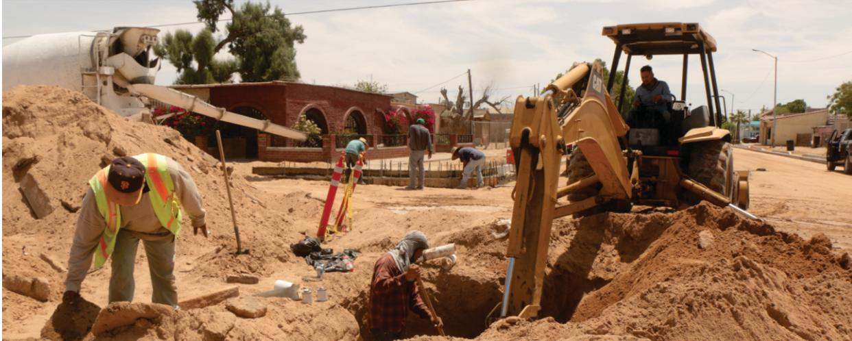
1. Instalación de 390 y 130 metros lineales de tubería de 4" de diámetro para la ampliación de la red de agua potable en el Sector Hídrico 11 en la Av. Canadá de la calle 29 a la 32 y en la Av. Bolivia de la calle 30 a la 31. Con una inversión de \$43,541.00 para beneficio de 160 habitantes, obra realizada del 15 al 19 de febrero 2019.
