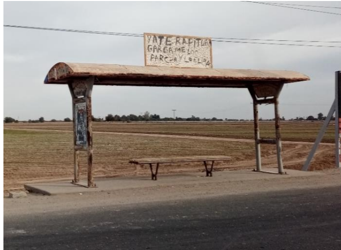
IMAGEN 79. PARADERO DE AUTOBÚS EXISTENTE FUENTE: IMAGEN PROPIA 2019
